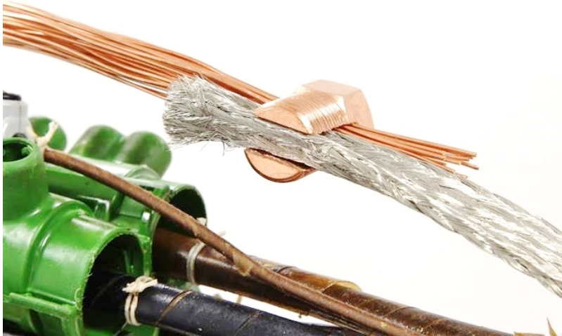
1 - Aardschermdraden en aardlitze in de vork van de moerklem plaatsen.
